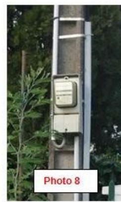
Compteur extérieur apparent
